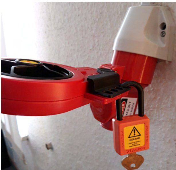
Verriegelung einer Starkstromsteckdose mit Kabelverriegelung S866 und Schloss
