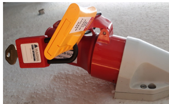
Verriegelung einer Starkstromsteckdose mit ELSCHYD und Schloss
